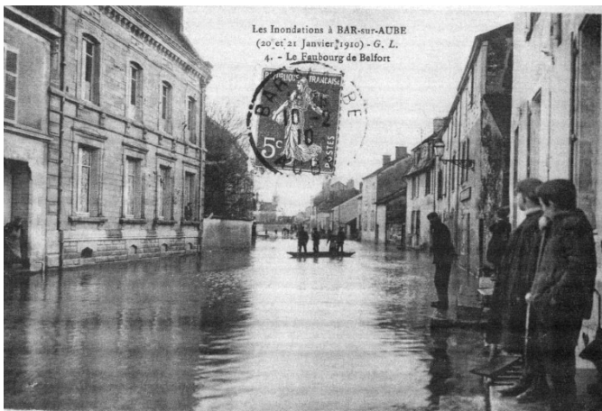
Bar-sur-Aube : Crue de 1910
