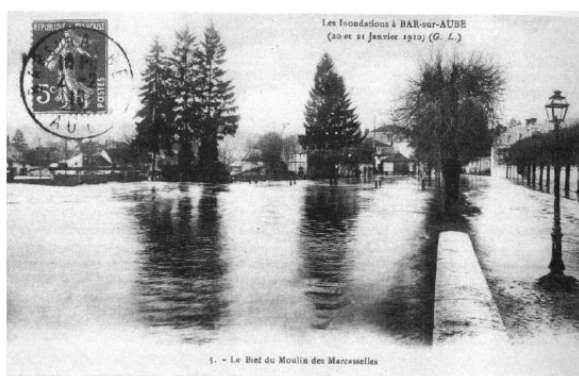
Le bief du moulin des Marcasselles
